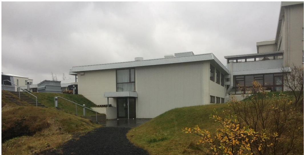
Mynd 1.2 Lóð hjúkrunarheimilisins. Gert er ráð fyrir að stutt sé niður á fast hraun á lóð hjúkrunarheimilisins. Uppfylling til landmótunar og tyrft yfir fyllingarefni.
